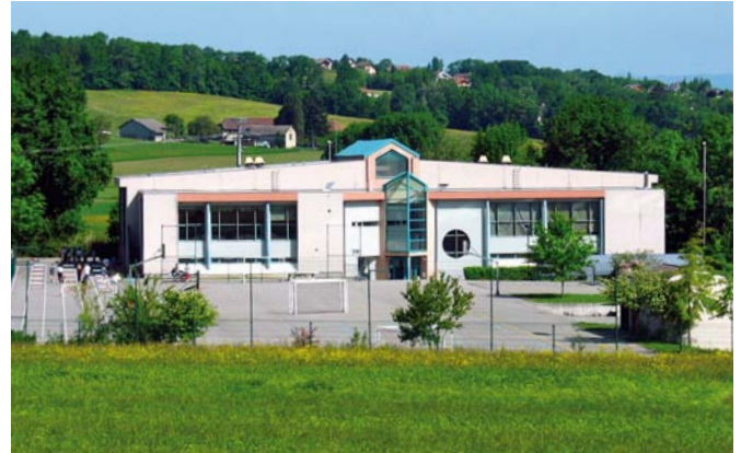
Le gymnase de la Mandallaz
